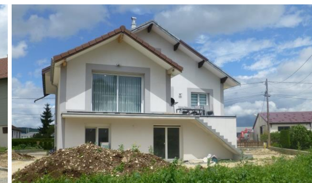
Vue arrière de la maison
