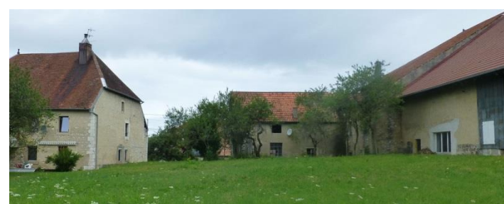
Composition de bâtiment de ferme, Ste-Colombe
