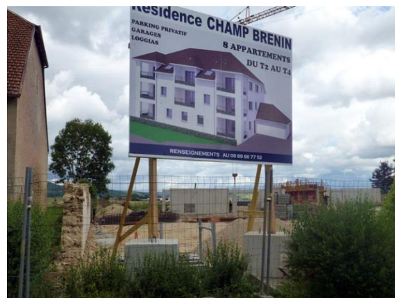
Démolition/reconstruction (relique du mur), Houtaud
