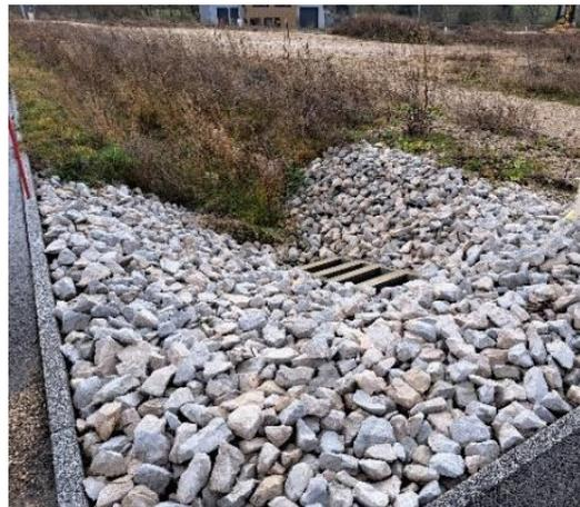
Figure 25 : Noue de collecte et d'infiltration des eaux pluviales temporairement en eau (2)
