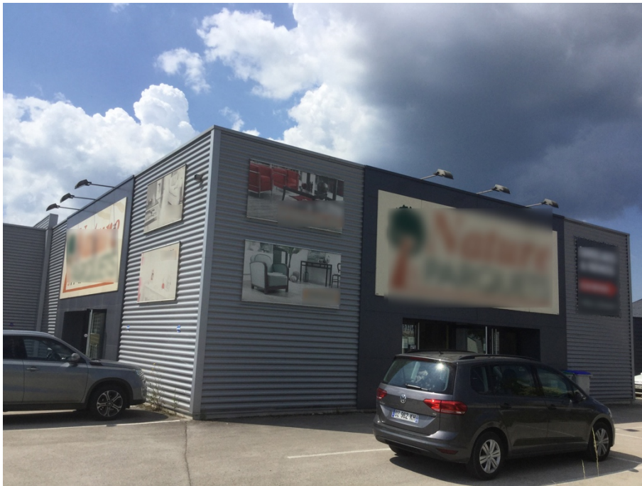
Surface d'enseigne en façade trop importante (art. R.581-63 C. Env.), ZA des Grands Planchants, Pontarlier, 2017
