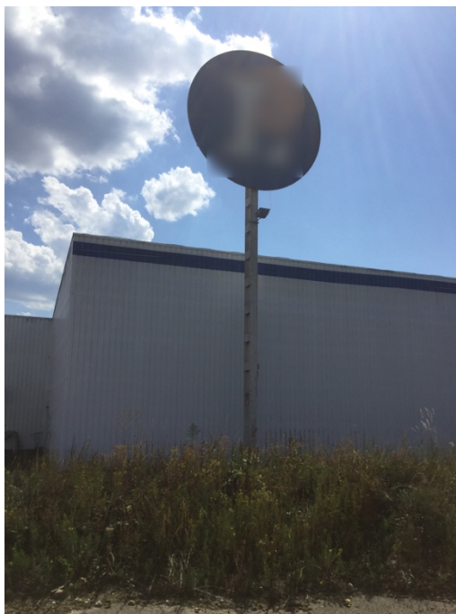
Enseigne scellée au sol dépassant > 6,5 m de hauteur (art. R581-65 C. Env.), Houtaud, 2017
