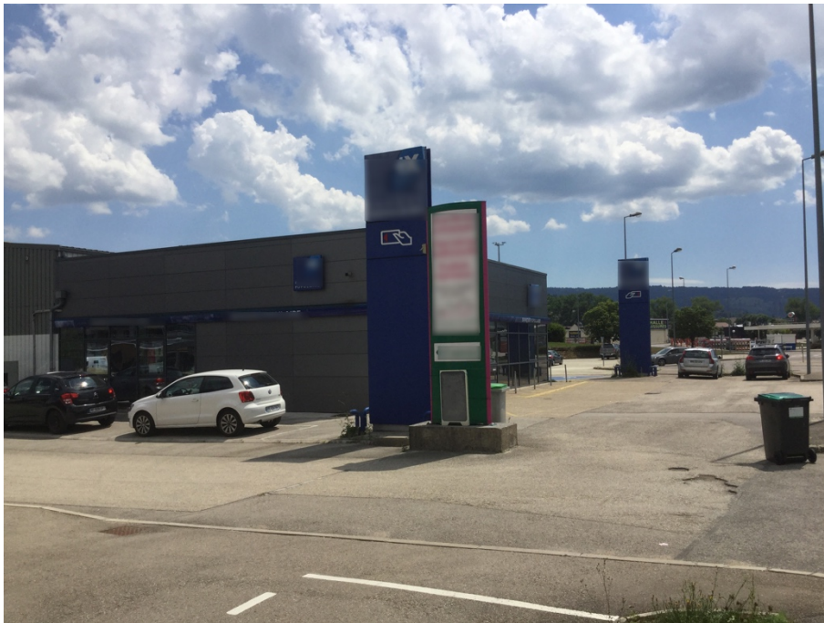
2 enseigne scellée au sol le long d'une même voie (art. R581-64 C. Env.), Doubs, 2017
