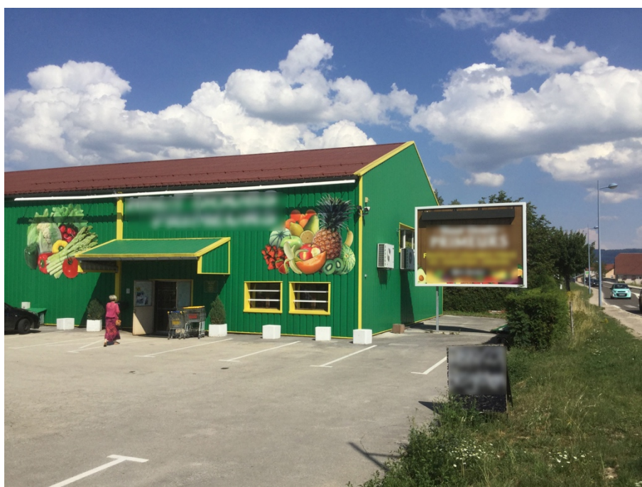
Enseignes en façade dont la surface est trop importante (art. R581-63 C. Env.), Houtaud, 2017
