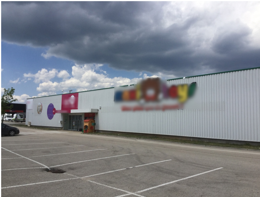
Enseigne parallèle dépassant les limites du mur (art. R581-60 C. Env.), Doubs, 2017
