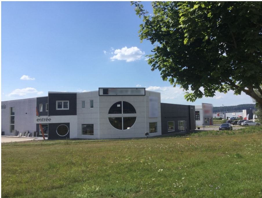
Enseigne parallèle dépassant les limites du mur (art. R581-60 C. Env.), Houtaud, 2017
