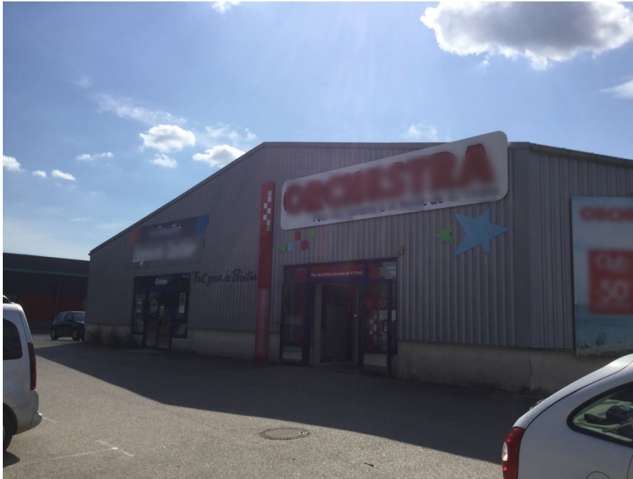
Enseigne parallèle dépassant les limites du mur (art. R.581-60 C. Env.), ZA des Grands Planchants, Pontarlier, 2017
