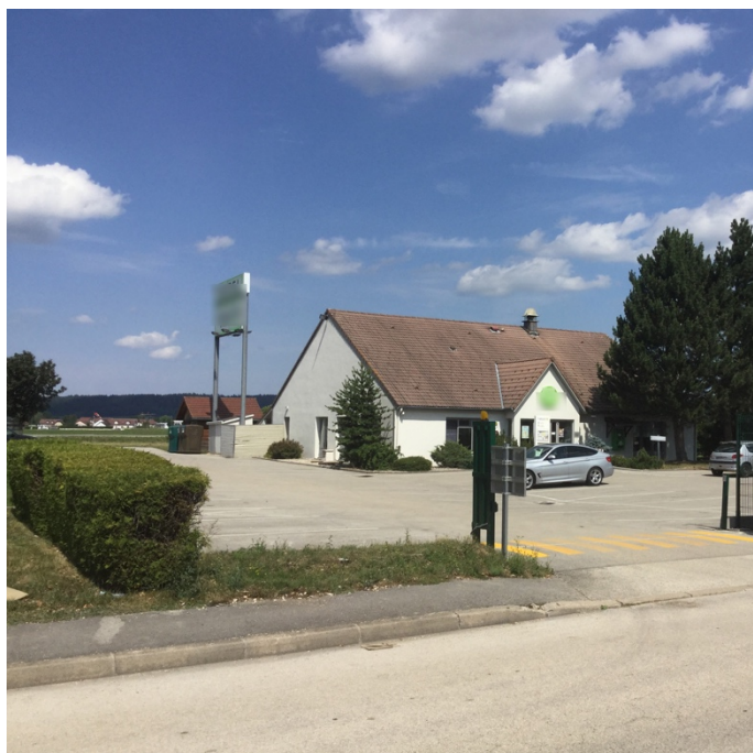
Surface de l'enseigne scellée au sol > 12 m 2 (art. R.581-65 C. Env.), ZA des Grands Planchants, Pontarlier, 2017
