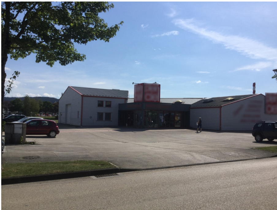
Enseigne sur toiture avec un panneau de fond (art. R.581-62 C. Env.), ZA des Grands Planchants, Pontarlier, 2017
