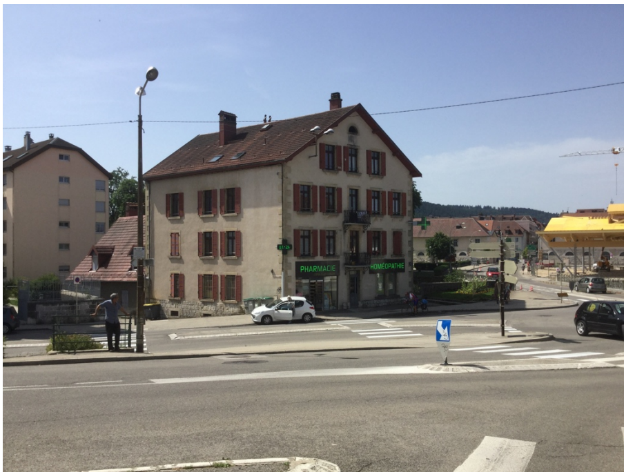
enseignes lumineuses, centre-ville de Pontarlier, 2017
